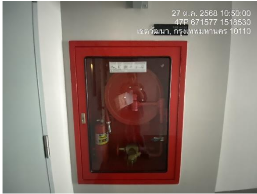
รูปที่ 13 ตู้เก็บสายฉีดน้ำดับเพลิง
