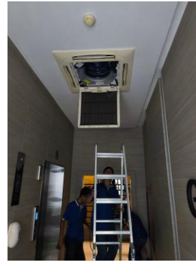
รูปที่ 27 ทำความสะอาดเครื่องปรับอากาศ
