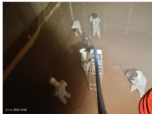
รูปที่ 37 ทำความสะอาดถังสำรองน้ำใช้
