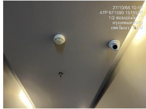
รูปที่ 14 เครื่องจับควัน
